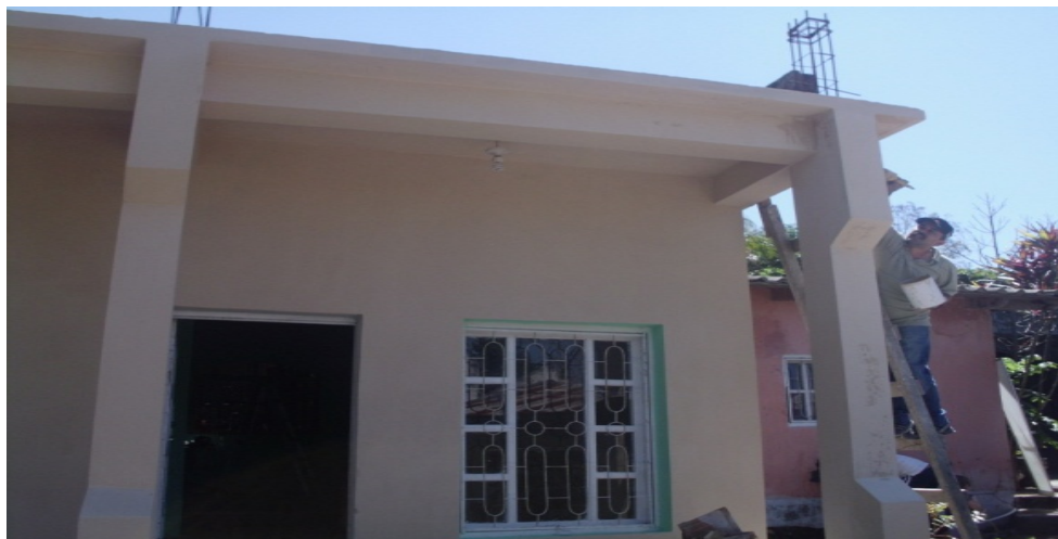
FOTO 14: SE OBSERVA LA FACHADA DESPUES DE LA REPARACION DONDE FUNCIONA LA UNIDAD EN EL MIRADOR
