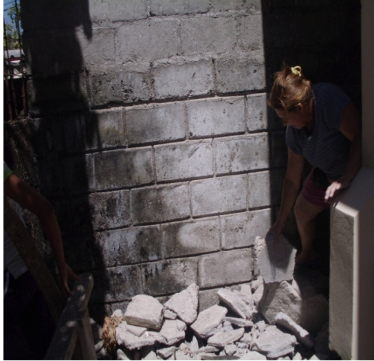
FOTO 12: ESTADO DE LA CASA ANTES DE REPARACION
