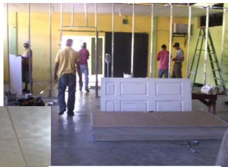
Miembros de la comunidad ayudan voluntariamente al reacondicionamiento del espacio donde funcionara la Unidad de Salud Familiar.
