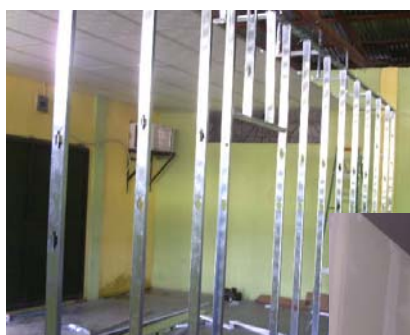
Reacondicionamiento del espacio facilitado por la comunidad, en el Centro Comunal de Gualjoco, Santa Bárbara.
